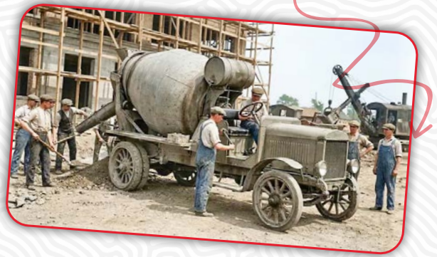
El primer camión hormigonera patentado en 1920
