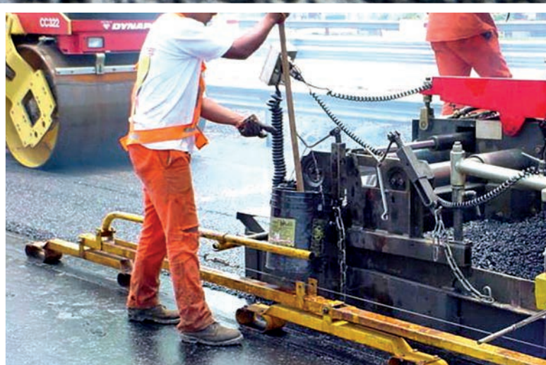
Colocación de un microaglomerado en caliente del tipo F10
