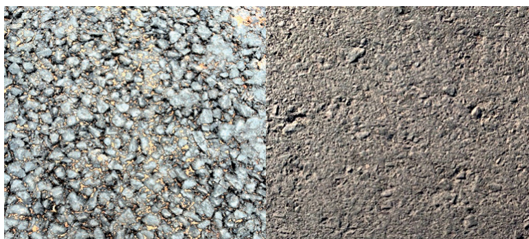
Diferencia entre una mezcla discontinua (izquierda) y convencional (derecha)
